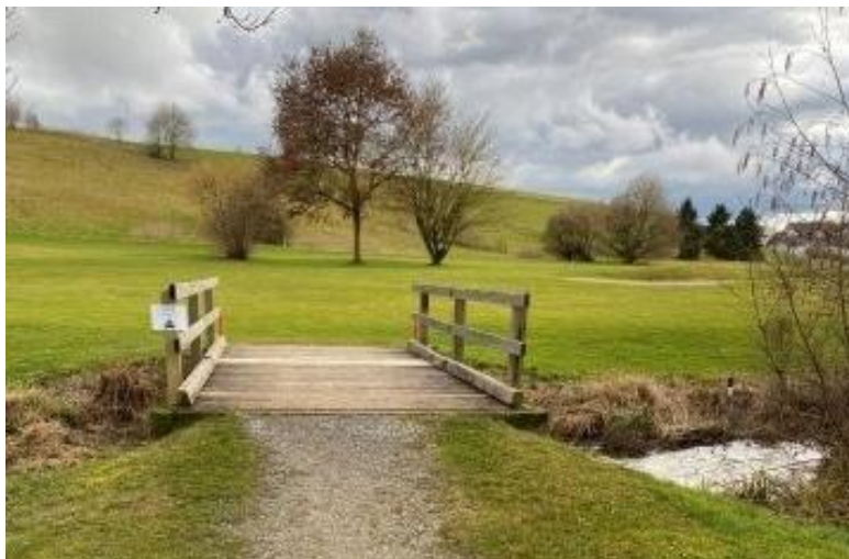
Anschlusspunkt des Fusswegs bei Brücke im Golfpark
