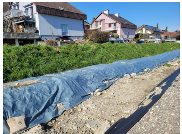
Abgedecktes PFAS-belastetes Aushubmaterial
