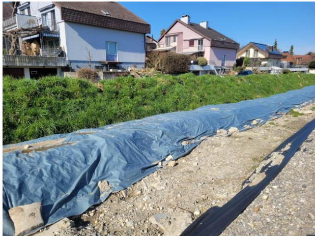
Abgedecktes PFAS-belastetes Aushubmaterial
