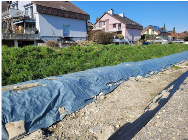
Abgedecktes PFAS-belastetes Aushubmaterial
