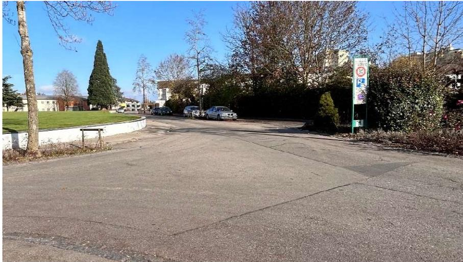
*allg. Zustand Allmendstrasse (Flicke, sanierte Fugen)*
