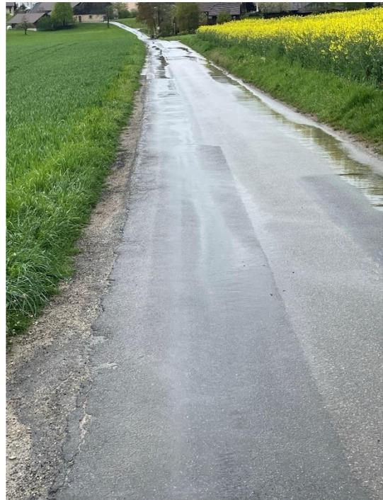
In diesem Abschnitt ist ein Hocheinbau ohne weitere Sanierungsmassnahmen ebenfalls nicht möglich. Es sind Massnahmen analog Etappe 2 zu planen. Grundsätzlich ist der Belag in einem besseren Zustand, jedoch sind auch hier viele Risse vorhanden, welche ohne Sanierung zu starken Schäden und dadurch zu erhöhten Sanierungskosten führen würden. In diesem Bereich ist der Belagsrand in einem schlechten Zustand. Der Belag muss an Randstellen, inklusive Koffer, ersetzt werden.
