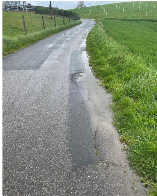
In diesem Abschnitt ist der Belag in einem deutlich schlechteren Zustand. Zahlreiche Rissbildungen, Belagsrandrisse und Abplatzungen sind entlang der Etappe 2 vorhanden. Ein Hocheinbau ohne weitere Sanierungsmassnahmen ist nicht sinnvoll. In absehbarer Zeit würden sich wieder Risse bilden.
