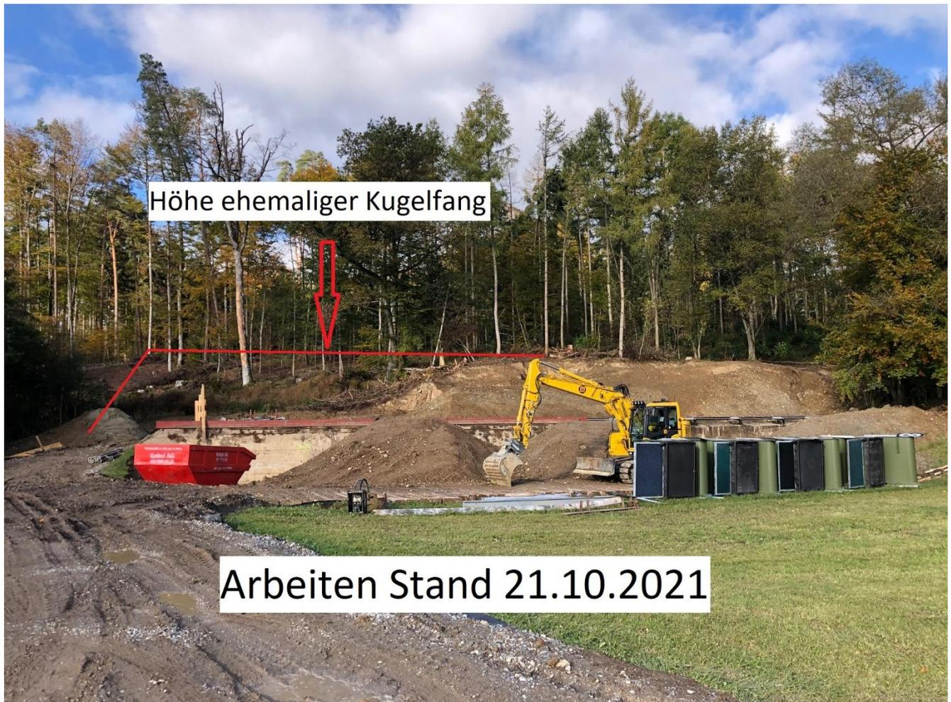
Fortschritt von den Bodensanierungsarbeiten: Ihr seht, wir haben bei der 300-m-Anlage bisher recht viel Boden abtragen müssen. Mehr als wir aufgrund vom vorgängig eingeholten Bodensanierungskonzept ursprünglich erwartet haben. Wir vermuten, dass sich unter der jetzigen Schiessanlage auch die ursprüngliche Schiessanlage befunden hat und wir jetzt den Boden von quasi zwei Schiessanlagen sanieren.
