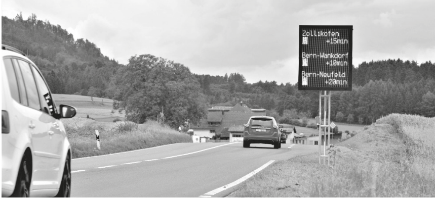
Verkehrsinformationstafel mit Testbild auf der Bernstrasse zwischen Hindelbank und Urtenen (Bild: A. Maradan)
