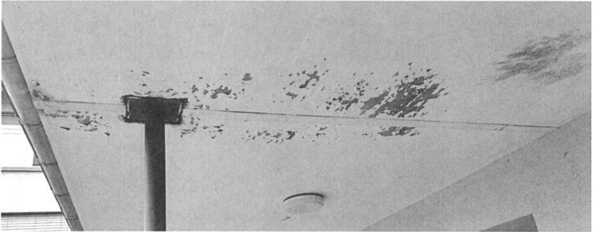
Untersicht Passarelle Bodenacker
