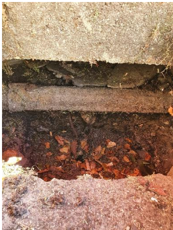
Wasserleitung durch ES 10
