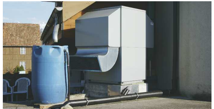
Baubewilligungspflichtige Luft/Luft-Wärmepumpe mit Luftbezug ausserhalb des Gebäudes
