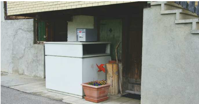
Baubewilligungspflichtige Luft/Luft-Wärmepumpe mit Luftbezug ausserhalb des Gebäudes
